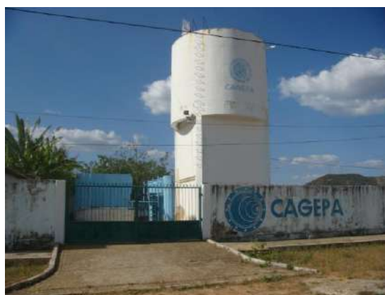
Reservatório Elevado de 100m 3 e ETA
